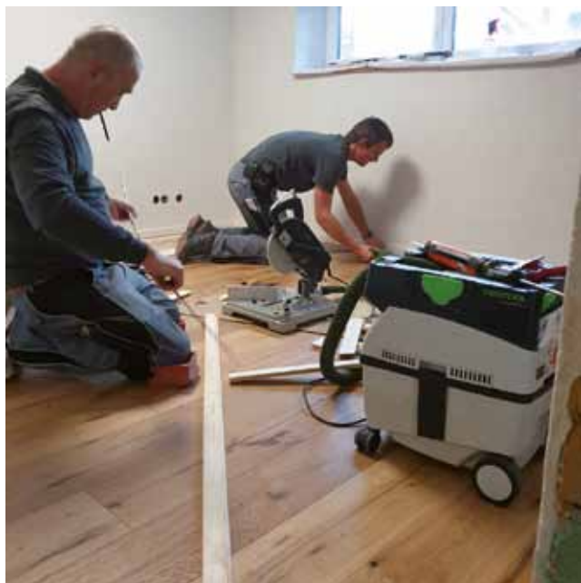
Christoph Wörner baut gemeinsam mit einem Mitarbeiter den neuen Parkettboden ein (Foto: pr)
