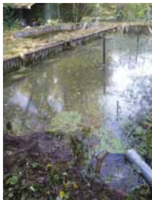
Ursprünglich waren die Teiche mit Spundwänden eingefasst.
