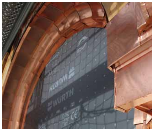
Die Zifferblattgaube erstrahlt in neuem Kupfer. (Fotos: SH)
