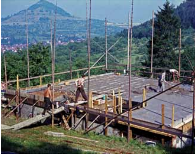
Viel schweißtreibender, ehrenamtlicher Einsatz erforderte der Hausbau als 1964 damit begonnen wurde. (Fotos: pr)
