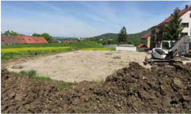
Hier in der Achalmstraße 71/1 entsteht zur Zeit das Kernstück der neuen Flüchtlingskonzeption. Nach dem 3-Säulen-Modell werden dort neben sozial Schwachen und Obdachlosen auch 30 Flüchtlinge untergebracht werden. (Foto:BW)
